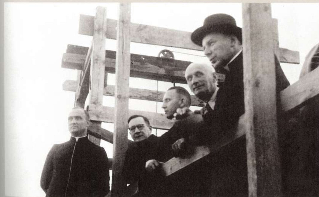
Na rusztowaniach odbudowywanej katedry warszawskiej
